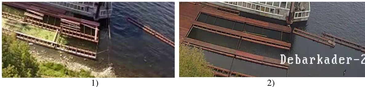
Рис.2. Причальная зона дебаркадера с ограждающими понтонами
