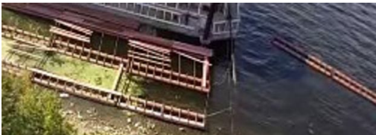
Рис. 2. Загрязнение причала дебаркадера сине-зелеными водорослями при неэффективной защите понтонами
